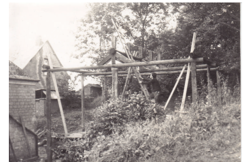
1968 : rehausse du faîtage de la charpente de la scène
