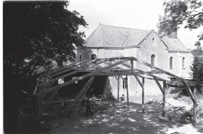
1988 : Bernard Deschodt et Bruno Moreaux à la réalisation des plots pour accueillir les poteaux de la structure
